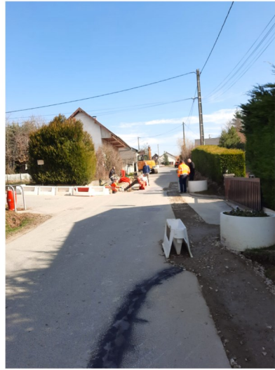
Travaux à Véry
