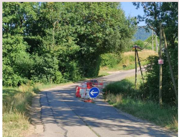
Chantier entre Buaz et Ballaison
