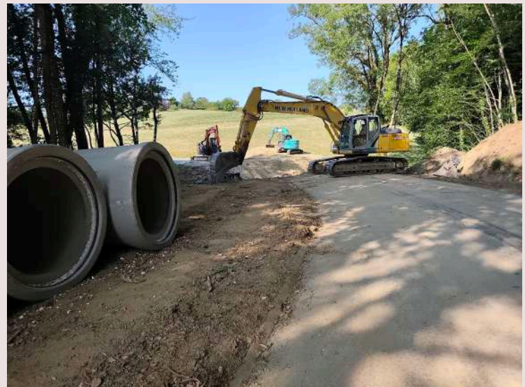
Travaux en cours sur la RD3
