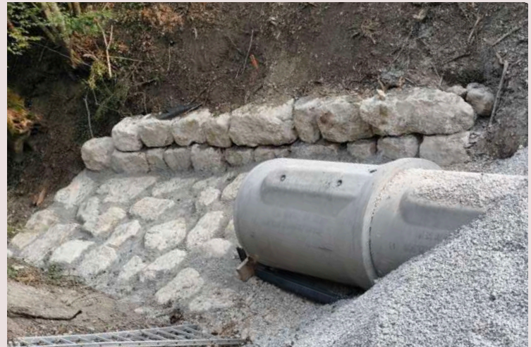
Travaux en cours sur la RD3
