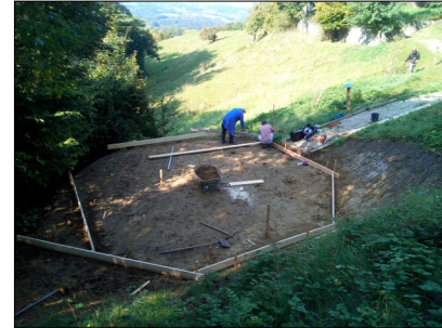
Coffrage de la gloriette
