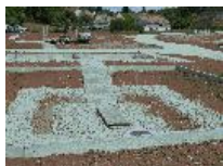
Ouvrage de comptage profond
